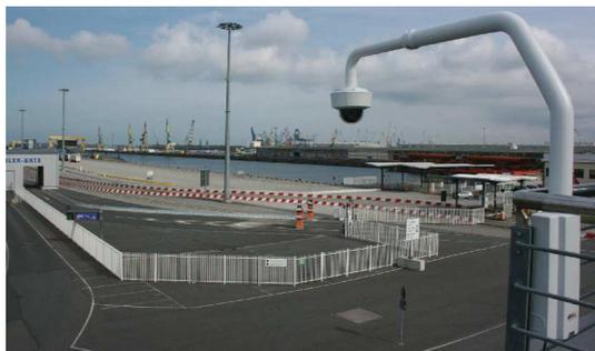
Figura 15.3f Esempio di telecamera montata su parapetto su un tetto
